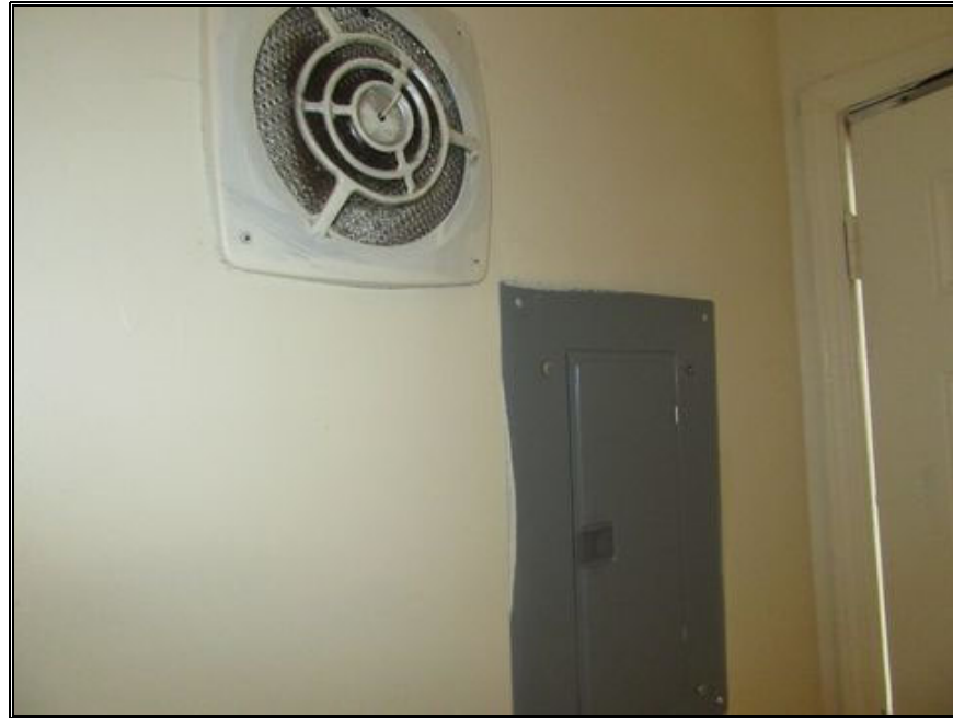
P81-Kitchen Exhaust Wall Fan
